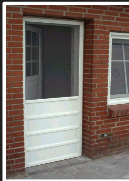
Ekstra fodplader sikrer stabilitet ved udsatte døråbninger med stor og grov trafik / ekstra udstyr
